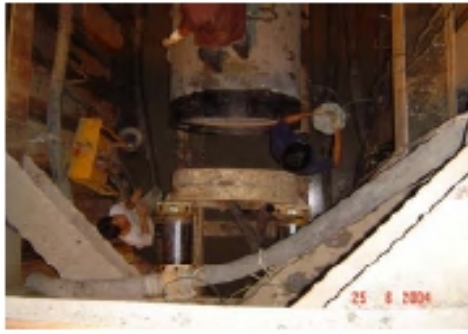
ภาพที่ 25 ติดตั้ง Steel Ring เพื่อกระจายแรง กดที่กระทำต่อท่อ
