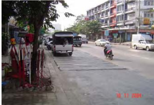
ภาพที่ 49 คั้นผิวจราจรชั่วคราวโดยการปิดด้วยแผ่นคอนกรีต
