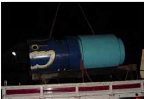
ภาพที่ 22 ทำการยกชุดหัวเจาะเพื่อนำลง ติดตั้งภายในบ่อ
