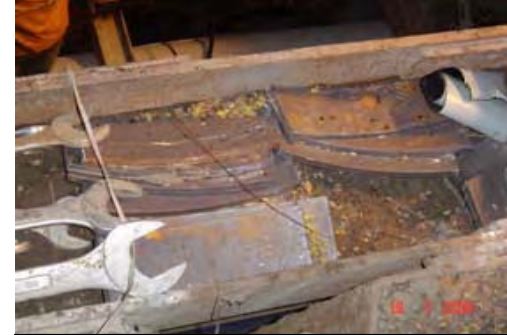
ภาพที่ 45 แผ่นเหล็กที่ติดตั้งจะเป็นส่วน รับแรงครูดขณะร้อยท่อ
