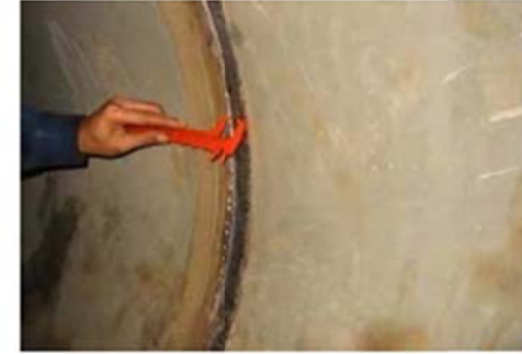
ภาพที่ ๖.๕ ทำการตรวจสอบขนาดของ รอยเชื่อมด้วยเวอร์มิเยอร์ โดยจะต้องเชื่อม พอกให้ได้ขนาดรอยเชื่อมตามมาตรฐาน
