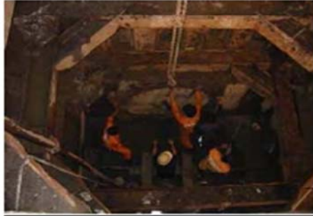
ภาพที่ ๑๕ ทำการเข้าแบบเพื่อเตรียมการหล่อ Concrete Ring สำหรับเป็นช่องทางค้ำให้หัวเจาะพร้อมท่อค้ำพื้นบ่อออกไปและเป็นการป้องกันดินนอกบ่อไหลเข้ามาในบ่อ
