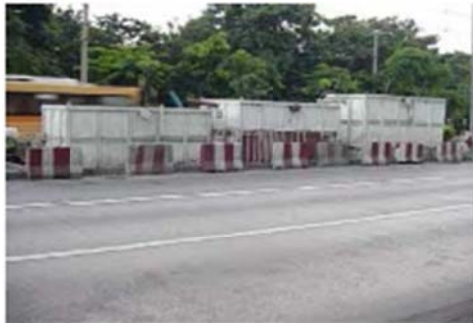
ภาพที่ ๖.๓ แสดงตำแหน่งการตั้ง สารละลายโพลิเมอร์จะไหลลงข้างฝาไปตั้ง อีกบ่อหนึ่งเพื่อมากลับไปใช้ใหม่
