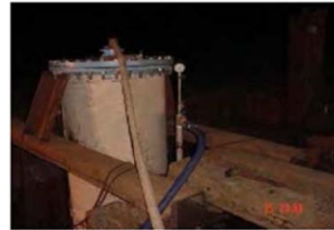
ภาพที่ ๖๘ ทดสอบแรงดันที่ ๐.๓๕ ksc ที่วางไว้ 2 ชม. จะต้องมี ไม่ลดลงเกินกว่า 0.35 ksc
