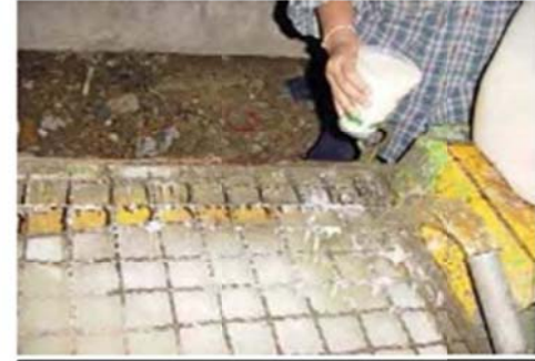
ภาพที่ ๑.๖ แสดงเครื่องมือผสมสารละลายโพธิเมอร์ สำหรับการรักษาเสถียรภาพของดินในหลุมเจาะและลดแรงเสียดทานด้านข้าง
