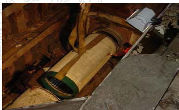
ภาพที่ 11 การค้ำท่อคอนกรีตที่มีท่อเหล็กเป็นท่อวงใน
