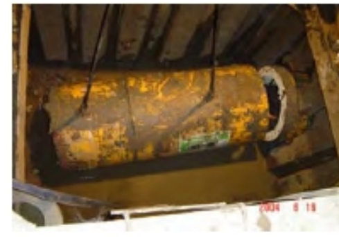
ภาพที่ 30 เมื่อดันท่อจนหัวเจาะไป โผล่ยังบ่อรับ
