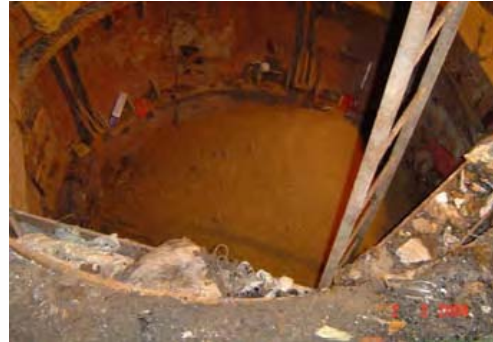
ภาพที่ 56 ขณะรื้อถอนบ่อรูปวงกลมจะต้อง บดอัดทรายเป็นชั้นๆพร้อมๆกับการรื้อถอนบ่อ
