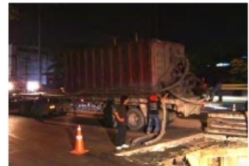
ภาพที่ 18 Muck Tank ที่ใช้เก็บตะกอนดินแบบ ภายในบ่อจะแบ่งออกเป็น 2 ส่วนส่วนที่เก็บ ตะกอนดิน และส่วนรีไซเคิลน้ำ
