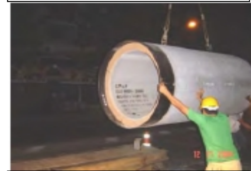
ภาพที่ 24 การยกท่อปลอกคอนกรีต
