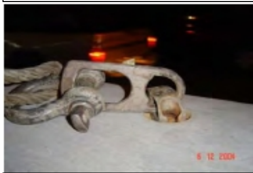
ภาพที่ 23 การเคลื่อนย้ายท่อปลอกคอนกรีต สามารถใช้ขอเกี่ยวที่ขอเหล็กของตัวท่อคอนกรีตได้
