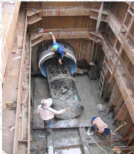
ภาพที่ 2.6 การลำเลียงดินออกมาทิ้งโดยใช้ Skip Car จากหัวเจาะแบบ Blind Shield
