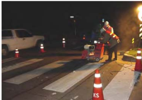
ก่อสร้างบ่อ
