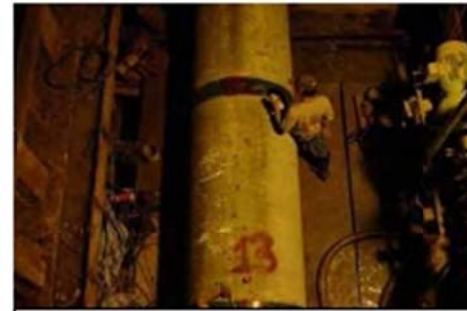
ภาพที่ ๔๘ ยกท่อท่อนต่อไปลงติดตั้งเพื่อ ทำการค้ำต่อไป
