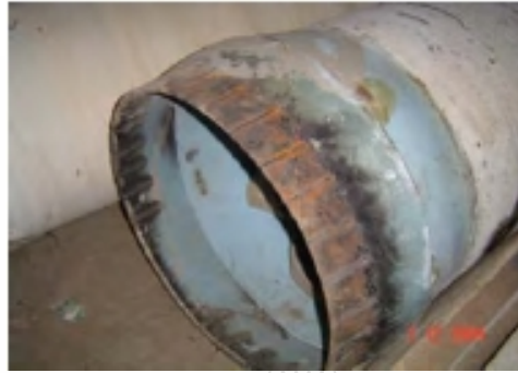
ภาพที่ 32 ปากท่อปากระฆังท่อนแรกจะต้องทำการติดตั้งปากระฆังตัวเมียเพื่อใช้เป็นส่วนรับการครูดตัว
