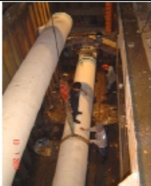
ภาพที่ 40 ภายในบ่ออาจมีการ Stockท่อเหล็กไว้ เพื่อประหยัดเวลาในการขนส่งท่อ
