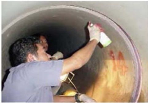
ภาพที่ ๔.๑ ทำการทดสอบความสมบูรณ์ของรอยเชื่อมโดยวิธี Liquid Penetrant Test
