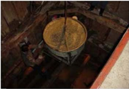
ภาพที่ ๑๑ เพื่อกองกริดหยาบพื้นบ่อเพื่อรองรับระบบการดันท่อ (Jacking System)
