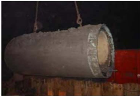
ภาพที่ ๖๖ ทำการยกท่อดินท่อนแรกขึ้นจาก บ่อรับ
