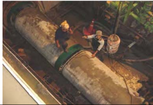
ny RC Pipe คั่นท่อ SCP
