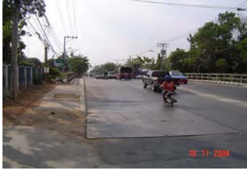
ภาพที่ 50 แสดงการปิดบ่อด้วยแผ่นเหล็กพร้อมซีลขอบแผ่นเหล็กด้วยแอสฟัลท์
