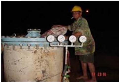
ภาพที่ ๖๙ แสดงการติดตั้ง pressure gauge เพื่อตรวจสอบแรงดันที่ทดสอบ
