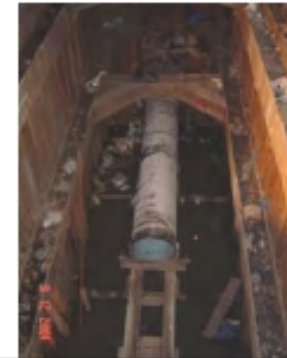
ภาพที่ 39 สลึงจะยึดติดกับท่อนเหล็ก ด้านหลังท่อเหล็กปากระฆัง ซึ่งจะคล้องและดันให้ท่อเหล็กปากระฆังร้อยเข้าไป
