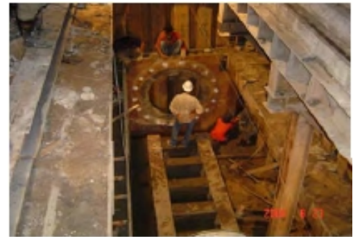
ภาพที่ 6 ติดตั้ง Safe Eye เป็นการช่วยป้องกันไม่ให้ดินบริเวณหน้าบ่อไหลเข้าสู่บ่อ
