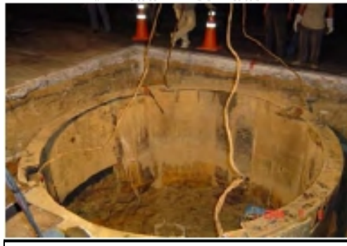
ภาพที่ 11 ติดตั้ง Segment ของบ่อรับ ชั้นส่วนแรก
