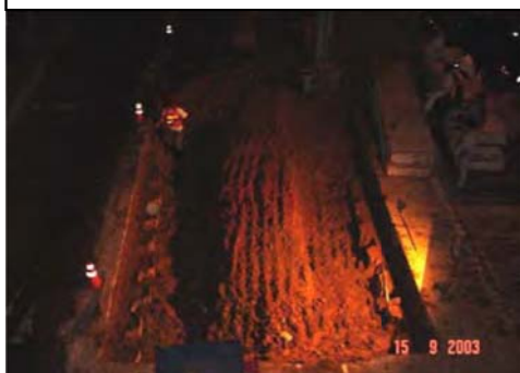
ก่อนติดตั้ง
