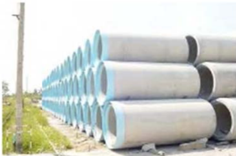
ภาพที่ ๔.๔ แสดงการกองเก็บท่อภายในสำนักงานโครงการเพื่อรอการนำออกไปใช้งาน
