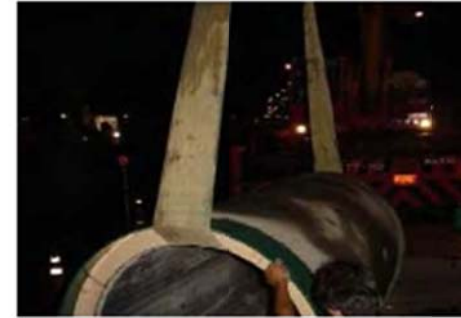
ภาพที่ 24 ทำการยกท่อดินท่อนแรกลง ประกอบด้วยชุดหัวเจาะ
