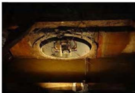
ภาพที่ ๔ ติดตั้งพัดลมเพื่อระบายอากาศ
