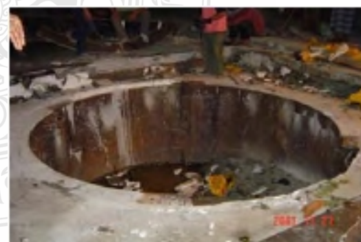
ภาพที่ 7 บ่อคั่นและบ่อรับแบบคอนกรีตเสริมเหล็ก
