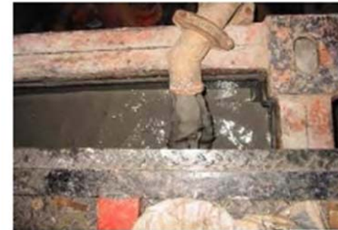
ภาพที่ ๖.๒ ลักษณะน้ำดิน สำหรับรับน้ำดิน เมื่อสูบขึ้นมาจากหัวเจาะก่อนขนไปทิ้ง
