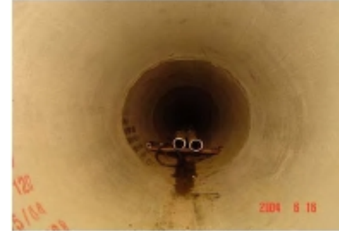
ภาพที่ 27 ติดตั้งระบบท่อลำเลียงดิน เพื่อปั๊ม น้ำดินออกมาทั้ง
