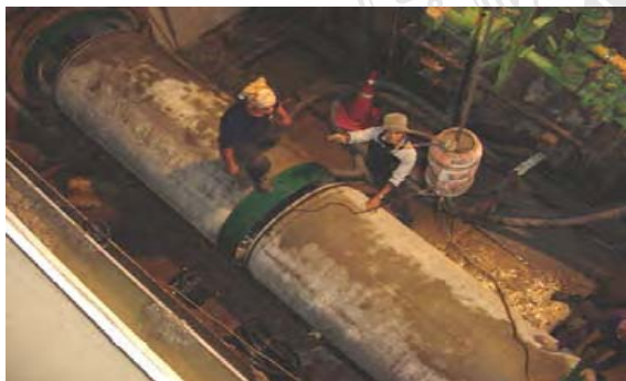
ภาพที่ 10 การค้ำท่อเหล็กเหนียวสองชั้น
