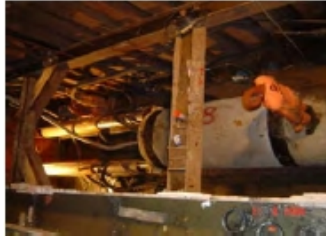
ภาพที่ 26 ดันท่อ จนกระทั่งครบตามความ ยาวท่อที่ต้องการ
