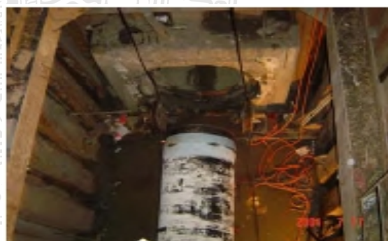
ภาพที่ 9 การร้อยท่อประปาเข้าไปในท่อปลอกคอนกรีต
