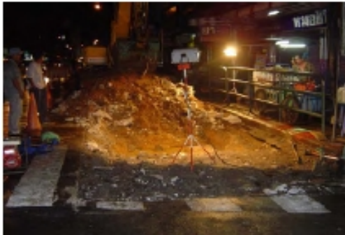
ภาพที่ 2 ทำการขุดเปิดผิวจราจร
