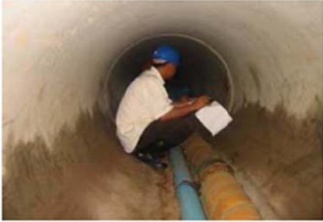
ภาพที่ ๖.๔ ท่อชนิดนี้จะสามารถเชื่อมได้ เฉพาะด้านในท่อเท่านั้น ดังนั้นจะต้องคอย ตรวจสอบคุณภาพของการเชื่อม
