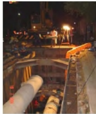
ภาพที่ 38 ใช้รถเครนดึงสลิงเพื่อดันปลายท่อเข้าไปยังท่อปลอกคอนกรีต
