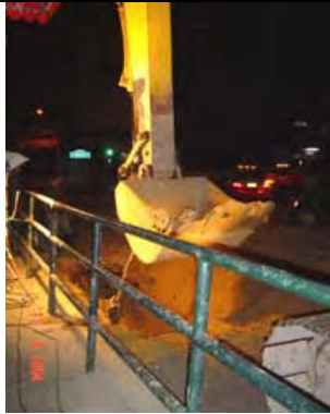
ภาพที่ 54 รีดอนบ่อและบดอัดทรายป็นชั้นๆตามไปด้วย เพื่อป้องกันการเคลื่อนตัวของดิน
