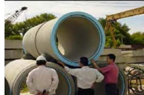
ภาพที่ ๔.๖ ทำการค่อท่อเป็นคู่ดังที่แสดงเพื่อเตรียมการยกลงไปสู่จุดดิน
