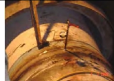
ภาพที่ 39 สลึงจะยึดติดกับท่อนเหล็ก ด้านหลังท่อเหล็กปากระฆัง ซึ่งจะคล้องและดันให้ท่อเหล็กปากระฆังร้อยเข้าไป
