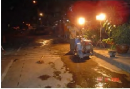
ภาพที่ 1 ใช้ไฟเบอร์ตัดพื้นคอนกรีต ก่อนทำการขุดเปิด
