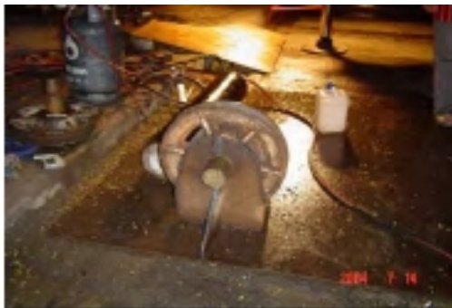
ภาพที่ 34 ลักษณะรอกที่เป็นตัวเปลี่ยนแนวตั้งท่อจากแนวราบเป็นแนวตั้ง
