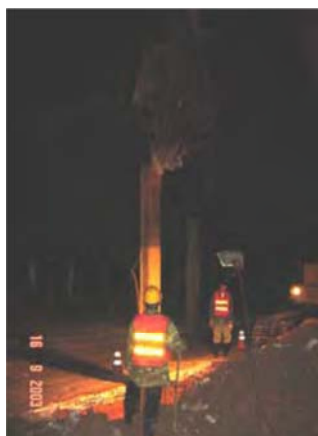
ได้เจนเพื่อ heet Pile
