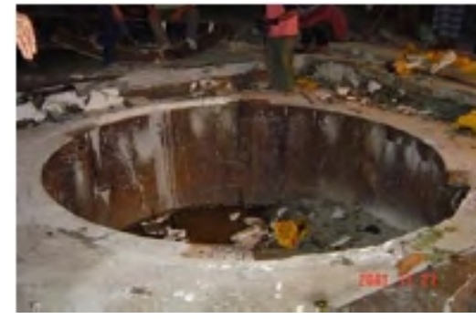
ภาพที่ 12 ทำการเทคอนกรีตยึดแนวจม บ่อรับให้อยู่ในแนวตั้ง
