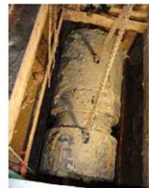
ภาพที่ ๖ ๒ ทิศหัวเจาะขึ้นจากบ่อรับ
