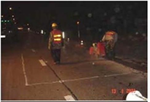
ภาพที่ 3. ทำการตัดผิวจราจรคอนกรีตด้วย เครื่องตัด
