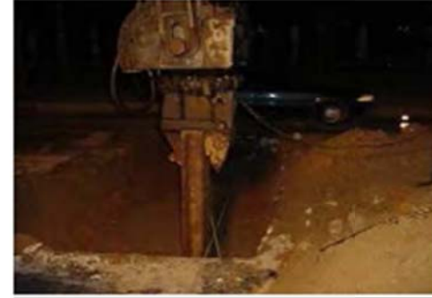
ภาพที่ ๗๑ देखимการรื้อถอนบ่อ โดยเริ่ม จากการถอน Sheet Pile และกำยั้น
