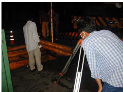
ภาพที่ 2.21 การกำหนดตำแหน่งบ่อด้วยกล้องสำรวจ
