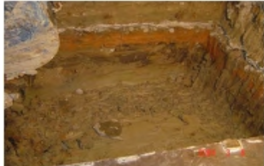
ภาพที่ 10 การก่อสร้างบ่อรับแบบทรงกระบอก กลมเริ่มจากการขุดดิน
