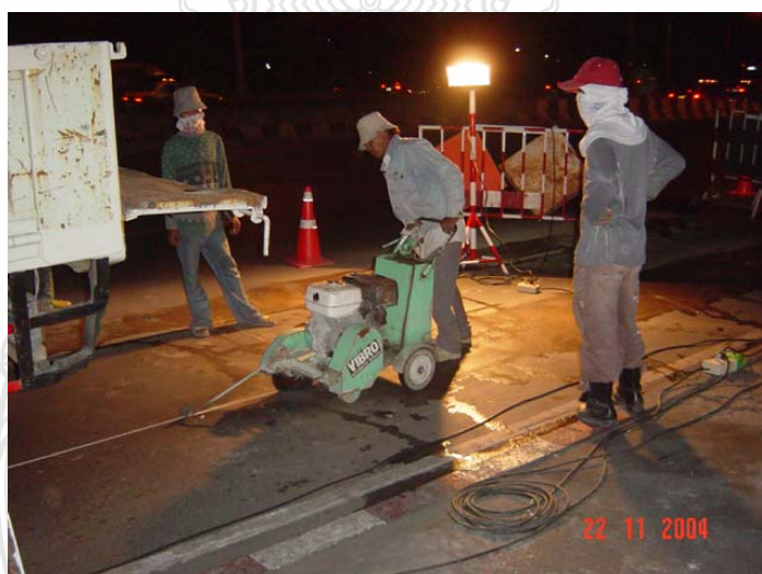
ภาพที่ 2.22 การตัดผิวจราจรด้วยเครื่องตัด
