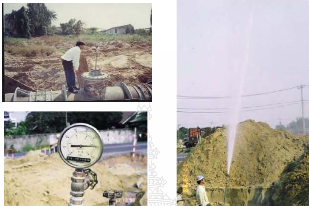
ภาพที่ 2.28 การทดสอบท่อด้วยความดัน 8 ksc. ใช้เวลาทดสอบไม่น้อยกว่า 2 ชม.
