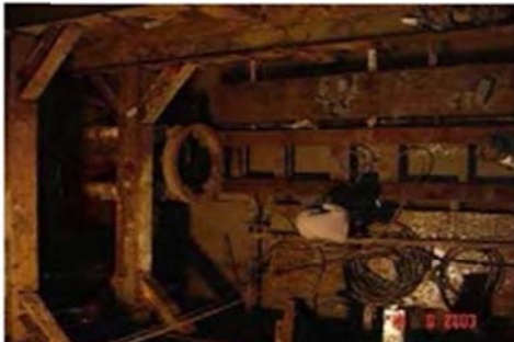
ภาพที่ ๔๙ ตรวจสอบแนวและระดับของท่อ ค้ำที่พื้นบ่อออกไป
