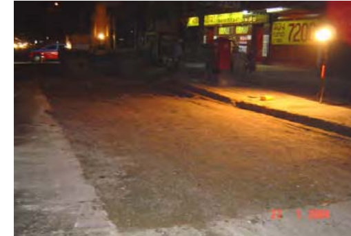
ภาพที่ 57 เตรียมการซ่อมผิวจราจรถาวรคืน สภาพเดิมตามมาตรฐานของหน่วยงาน เจ้าของ พื้นที่
