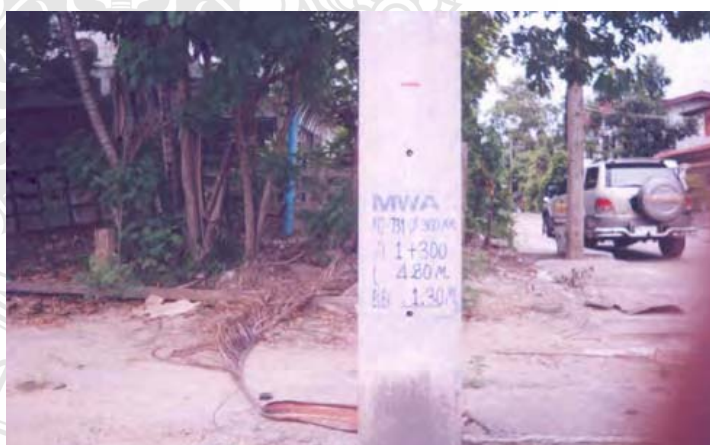
ภาพที่ 2.16 ตัวอย่างการทำแนวและระดับ (Line & Grade) ก่อนเริ่มการก่อสร้างวางท่อประปา
