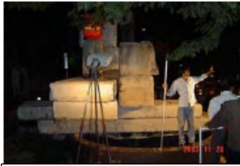
ภาพที่ 14 นำ Load ซึ่งเป็นแผ่นพื้น คอนกรีตมากดทับเพื่อจมนบ่อเหล็กลงไป
