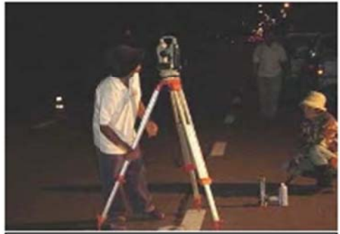
ภาพที่ 2. กำหนดตำแหน่งบ่อด้วยกล้องสำรวจ
