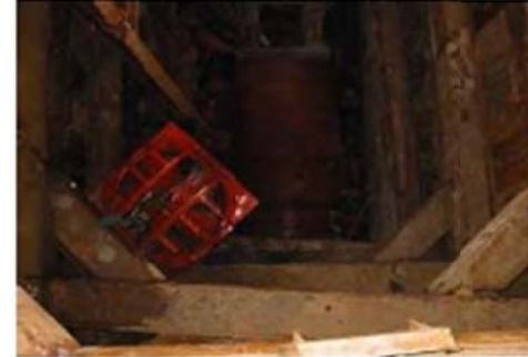
ภาพที่ 6 ติดตั้งพัฒนาระบายอากาศ (vent) ไว้ ภายในบ่อเพื่อลดมลพิษ โดยเฉพาะฝุ่นที่เกิดจากการเชื่อม
