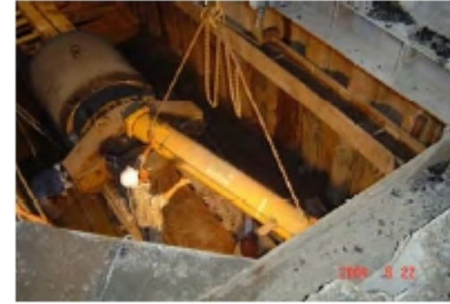
ภาพที่ 9 ติดตั้ง กระจกไฮโดรลิกส์และ ชุด Laser เพื่อควบคุมทิศทางการค้ำ
