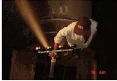
ภาพที่ ๗๐ ภายหลังการทดสอบจะทำการปล่อย น้ำสะอาดที่ใช้ในการทดสอบออกจากเส้นท่อ
