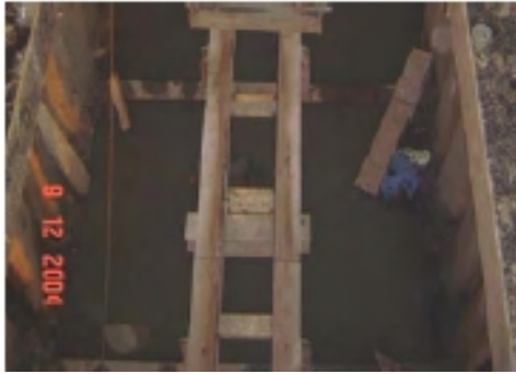
ภาพที่ 31 เปลี่ยนความกว้างของรางค้ำให้แคบลง และหนุนให้สูงขึ้น เพื่อไม่ให้เกิดรอยต่อเหล็กเหนียวติดท่อปลอกคอนกรีต
