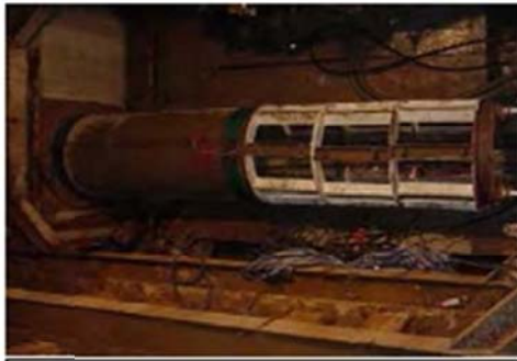
ภาพที่ ๑.1 ทำการติดตั้ง rebar ระหว่างชุดแม่แรงและท่อที่กำลังทำการคืน
