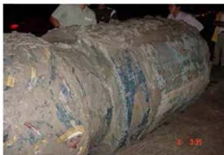
ภาพที่ ๖ แสดงสภาพของหัวเจาะภายหลังจาก ผ่านการคั่นท่อ
