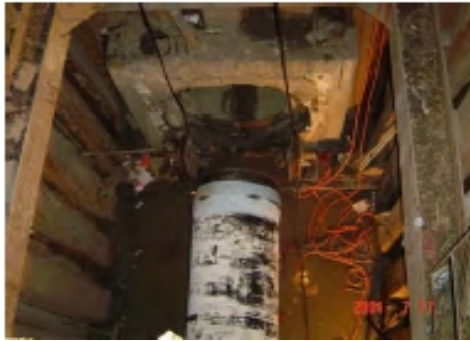
ภาพที่ 37 ใช้สลิงหย่อนท่อเหล็กเหนียว เพื่อเตรียมการร้อยเข้าไปในท่อปลอก
