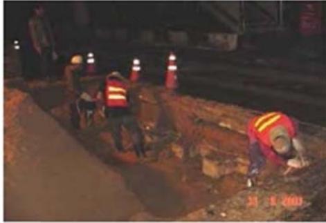
ภาพที่ 1 ติด steel pile เพื่อปรับระดับสำหรับ การติดตั้งถาวรรองรับขอบบ่อ
