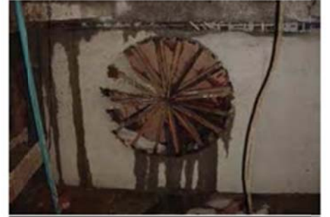
ภาพที่ ๑๖ เพื่อกองกริดแบบหล่อ Concrete Ring
