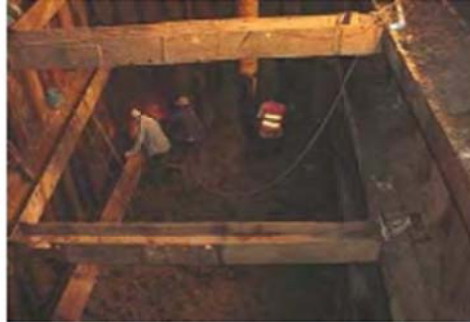
ภาพที่ 5 ทำการขุดดินและทำชั้นตาม ตำแหน่งที่ออกแบบไว้
