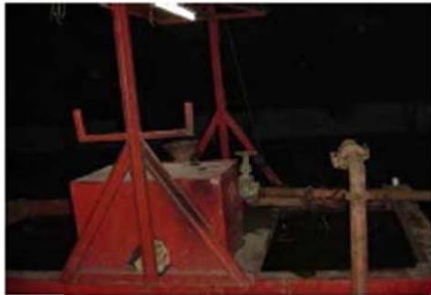
ภาพที่ ๖. แสดงบึงควบคุมระบบท่อเข้า และท่อที่น้ำดินออก
