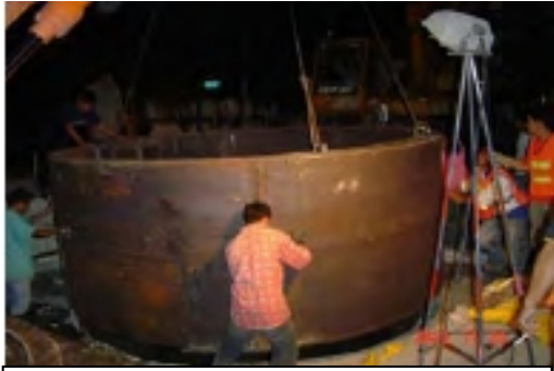
ภาพที่ 13 นำ Segment ท่อนต่อไปมา เชื่อมติดกับท่อนเดิม
