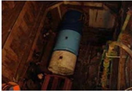
ภาพที่ 23 ทำการยกชุดหัวเจาะเพื่อนำลง ติดตั้งภายในบ่อ
