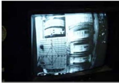
ภาพที่ ๑.๒ แสดงการควบคุมการคืนผ่านจอมอนิเตอร์ในห้องควบคุม
