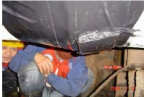
ภาพที่ 44 ด้านล่างของปากกระม้งจะติดตั้งแผ่น เหล็กโค้งหนาประมาณ 1 ซม. และทา Primer พร้อมติด Monotape ทับ
