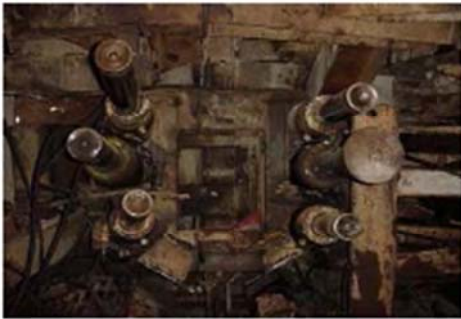
ภาพที่ 19 ทำการติดตั้งชุดแม่แรงไฮดรอลิก
