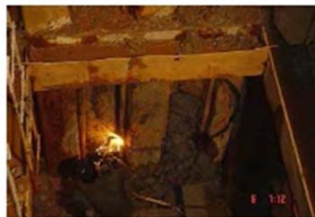
ภาพที่ ๖ ทำการติดตั้งบ่อรับบริเวณ ก่อนที่หัวเจาะจะทะลุมา
