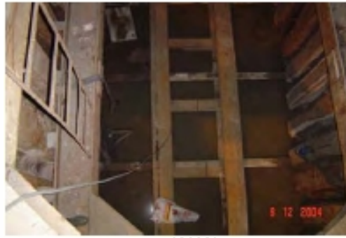
ภาพที่ 8 ติดตั้งรางค้ำท่อเพื่อเป็นการ ควบคุมแนวของท่อที่จะดันพื้นบ่อออกไป
