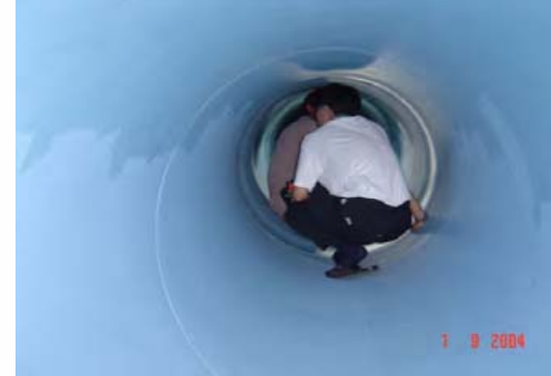
ภาพที่ 47 ตรวจสอบความสะอาดของท่อ รวมถึงการซ่อมสีภายในท่อบริเวณรอยเชื่อม
