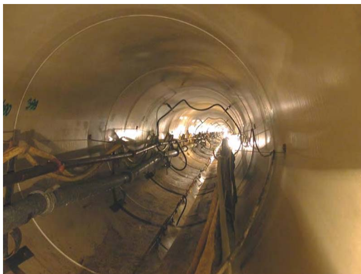
ภาพที่ 2.7 การลำเลียงดินออกมาทิ้งโดยใช้การปั๊มออกทางท่อจากหัวเจาะแบบ Closed Face Shield
