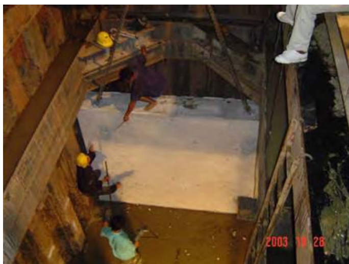
ภาพที่ 2.23 การติดตั้งกำแพงยันหลัง (Back Thrust Wall)
