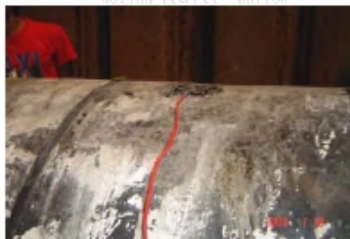
ภาพที่ 35 งานติดตั้ง Zinc Ribbon เพื่อเป็นระบบป้องกันการผุกร่อนของท่อเหล็กเหนียว
