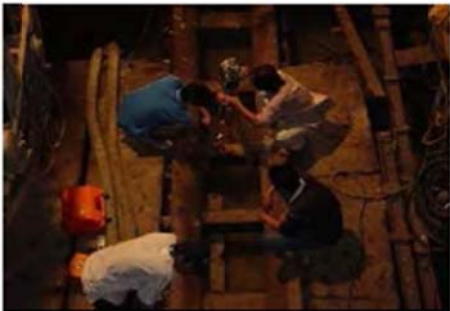
ภาพที่ ๑๔ ติดตั้งวงสำหรับค้ำท่อ
