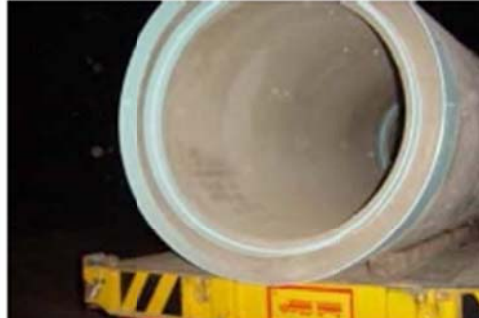
ภาพที่ ๔.๕ ทำการขนท่อจากสำนักงานโครงการไปยังจุดงาน โดยรถบรรทุก
