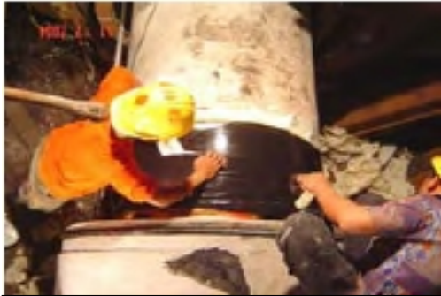
ภาพที่ 43 ป้องกันรอยเชื่อมโดยทา Primer และ พัน Monotape บริเวณปากกระม้ง
