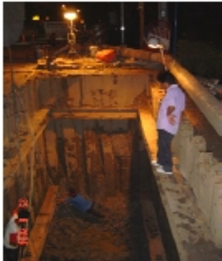
ภาพที่ 4 ติดตั้ง Bracing และขุดเปิดดินให้ได้ระดับที่ความลึกตามแบบบ่อที่ขอ
