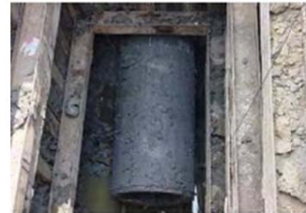
ภาพที่ ๖ แสดงท่อคั่นท่อนแรกที่โผล่ตาม หัวเจาะมายังบ่อรับ
