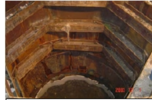
ภาพที่ 15 ติดตั้ง Bracing ให้ได้ระดับพร้อม เตรียมการเทคอนกรีต Base Slab
