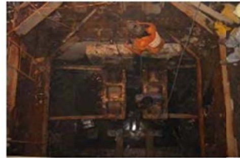
ภาพที่ ๑๓ ทำการติดตั้งกำแพงยันหลัง
