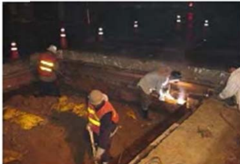
ภาพที่ 4 เชื่อมถาวรรองรับขอบบ่อกับ steel pile เพื่อเสริมความแข็งแรง
