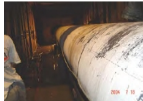
ภาพที่ 36 ทำการติดตั้ง Zinc Ribbon
