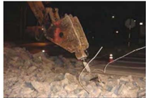
ภาพที่ 4. ทำการเจาะผิวจราจรคอนกรีต
