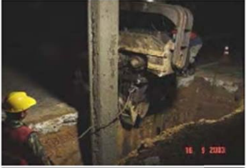
ภาพที่ 6. ทำการกด sheet pile ตามที่ ออกแบบ
