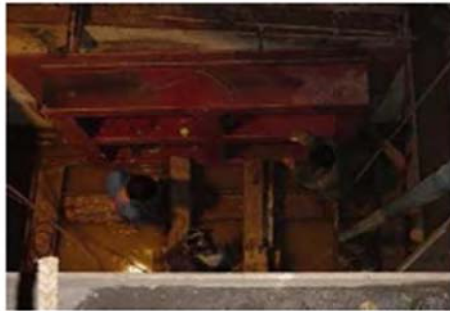
ภาพที่ ๑๒ เตรียมการติดตั้งกำแพงยันหลัง (Back Thrust Wall)
