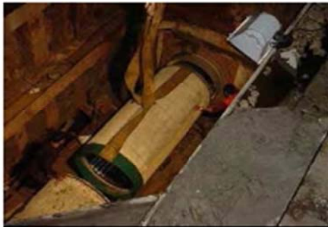
ภาพที่ ๑.๔ ทำการคืนท่ออย่างค้ำเนื่องเพื่อมิให้เกิดแรงเสียดทานที่มากขึ้น
