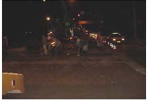
ภาพที่ 5. จุดเตรียมขบบ่อเพื่อเตรียมการกด Sheet Pile
