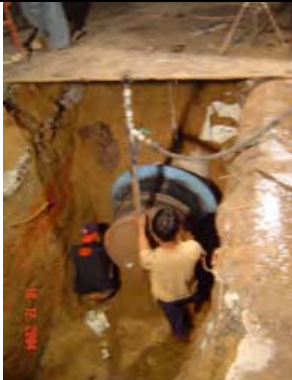
ภาพที่ 52 ทดสอบการใช้งานที่ 8 ksc ทิ้งไว้ 2 ชั่วโมงความดันไม่ลดลงเกินกว่า 0.35 ksc
