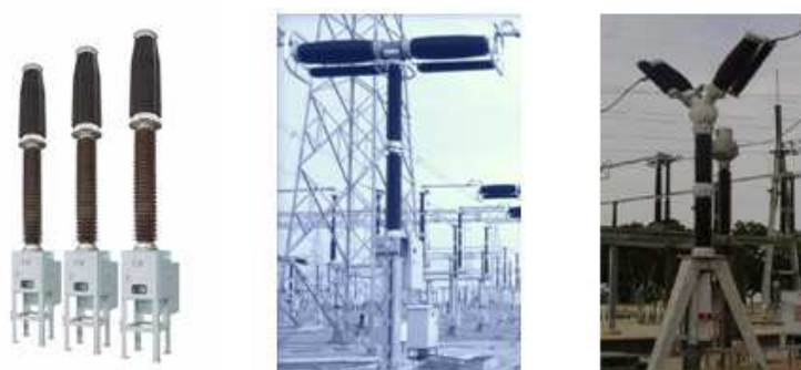
ภาพที่ 2.8 ลักษณะโครงร่างของสวิตช์ตัดตอนไฟฟ้าแรงสูง Gas SF 6 [6]
