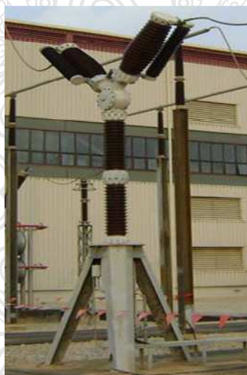
ภาพที่ 3.11 ภาพของสวิตช์ตัดตอนไฟฟ้าแรงสูง
