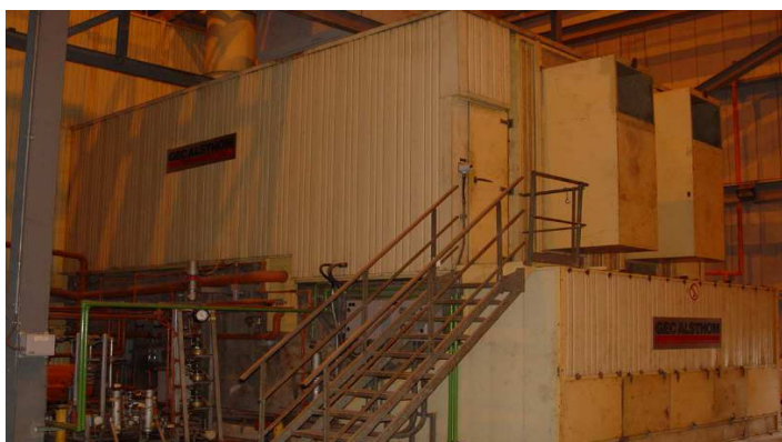
ภาพที่ 3.8 เครื่องกำเนิดไฟฟ้าโรงไฟฟ้าระยอง
