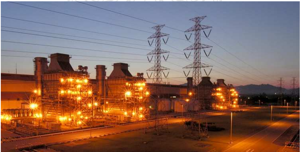
ภาพที่ 3.1 โรงไฟฟ้าพลังงานความร้อนร่วมระยอง
