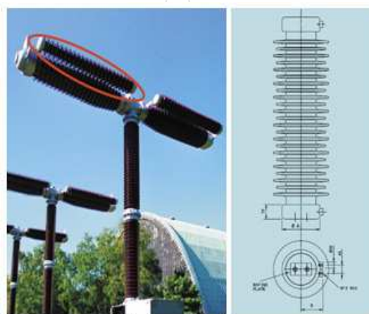
ภาพที่ 2.10 การต่อ Grading Capacitor ครอบ Interrupter [6]
