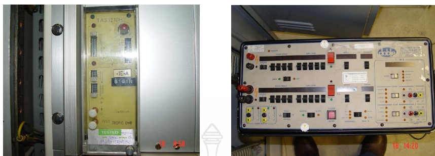
ภาพที่ 4.14 อุปกรณ์ป้องกันกระแสไฟฟ้ารั่วลงดินและเครื่องมือทดสอบ
