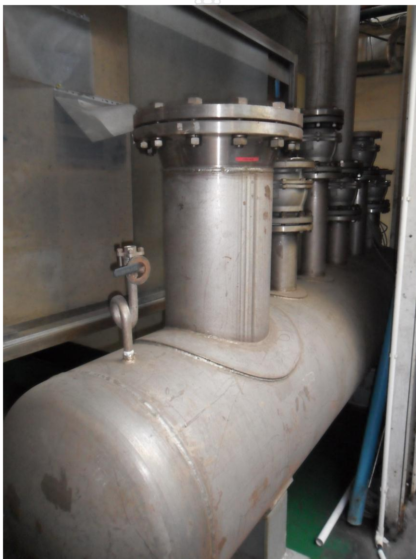
ภาพที่ 4.10 แสดงHeader แรงดันในระบบหล่อเย็น
